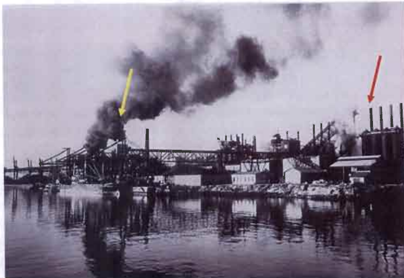
Figura 1: Altiforni della Ferreria di Servola, vista da mare - Anni '40
