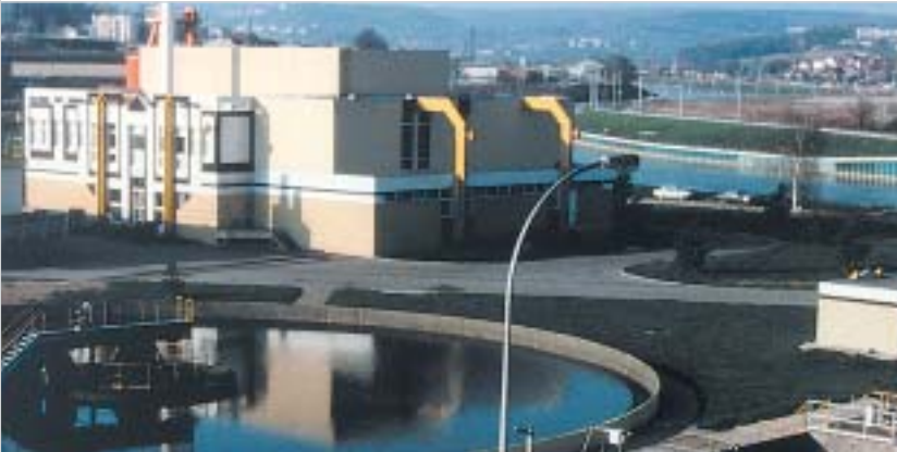
Impianto per il trattamento dell'acqua a Nancy.
