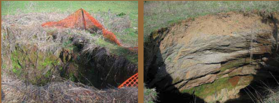
Figura 2.3.4 Voragine apertasi di recente nel parco della Caiaffa
