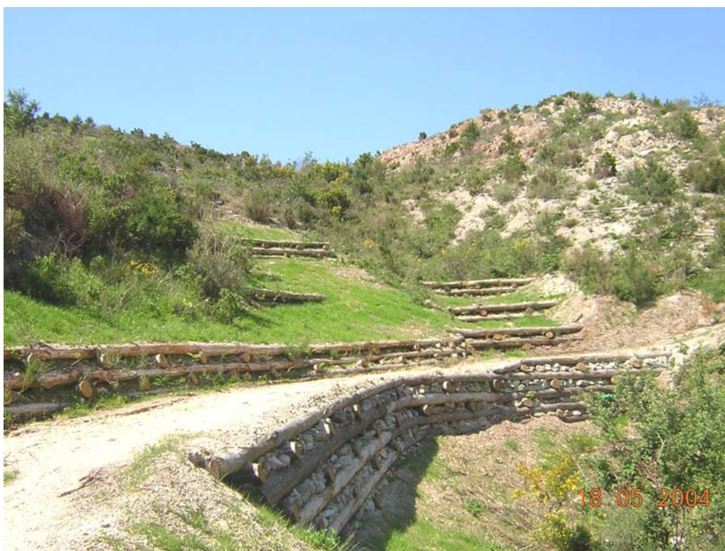
Esempio di palificate in legname a doppia parete, a 30 giorni dalla ripresa vegetativa Rio Crovetto, Spotorno (SV), maggio 2004 (foto U.Bruschini)
