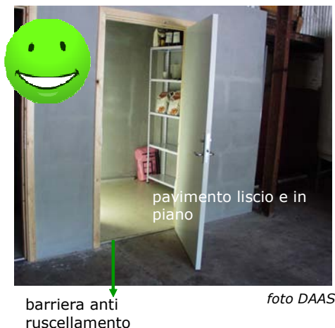
Fig. 25 – Il locale per lo stoccaggio degli agrofarmaci deve essere dotato di pavimento liscio e non scivoloso.
