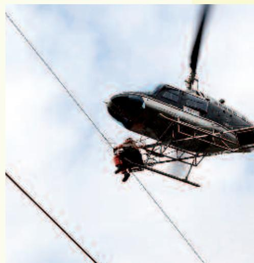
Messa in opera di spirali colorate su un elettrodotto di alta tensione della Piana Fiorentina e Pratese e in particolare nella zona di Bisenzio-Fi per mitigare l'impatto delle possibili collisioni con l'avifauna possibile grazie a un accordo WWF Italia.
