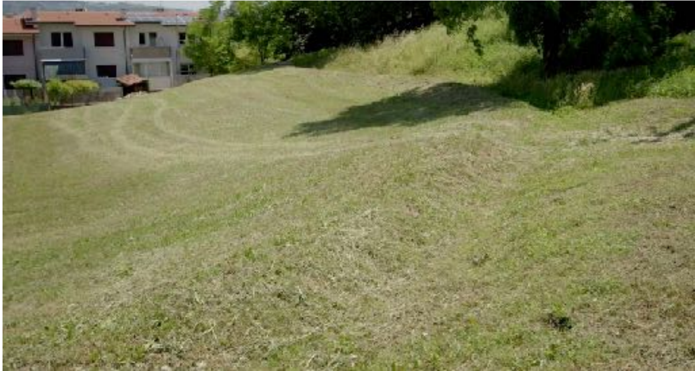
Canale di gronda inerbato
