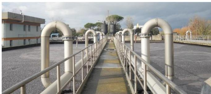
Figura 2: Vasche di ossidazione a fanghi attivi dell'impianto di depurazione Cuoiodepur, con particolare delle tubazioni per l'insufflazione dell'aria nelle vasche (foto: LIFE LESSWATT)
