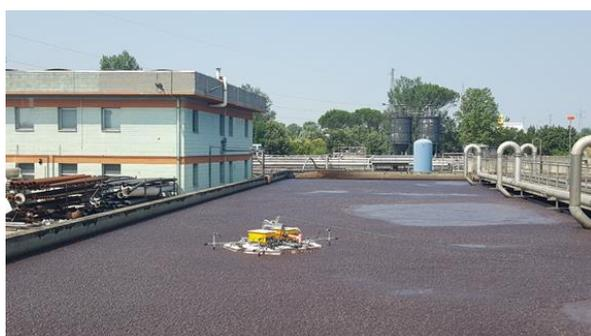
**Figura 4: Il Lessdrone in azione in una vasca di ossidazione di un impianto di depurazione (foto: LIFE LESSWATT)**
