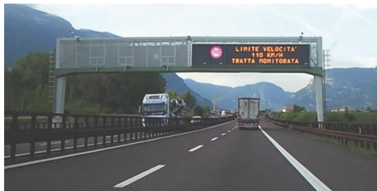
Figura 3: Limiti di velocità dinamici esposti nel tratto BLEC-ENV
