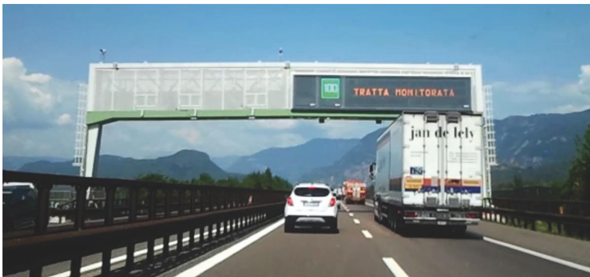
Figura 2: Messaggio di velocità consigliata sul pannello a messaggio variabile
