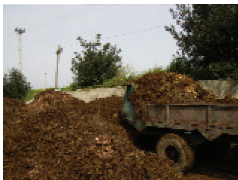
Riempimento trincea di compostaggio con l'ausilio dello spandiletame.
