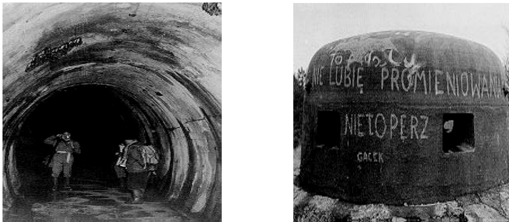
Figura 2.12 - Particolare interno ed esterno del bunker Miedzyrzecki in Polonia, dove svernano 12 specie di chiroteri (da Voute, 1991).
