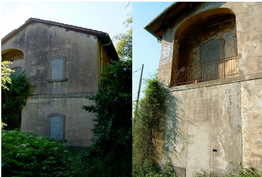
Figura 5.1 - Caselli ferroviari con porte e finestre murate.
