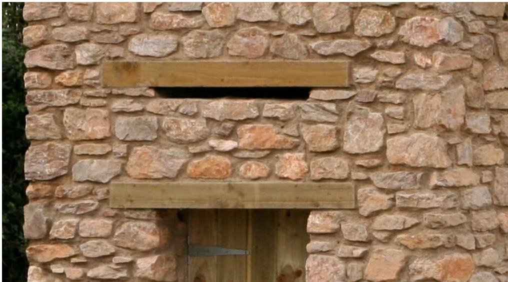
Figura 2.6 - Apertura utilizzabile dai chirotteri per l'ingresso in arrampicata (Foto David Ramsden, The Barn Owl Trust, 2006).
