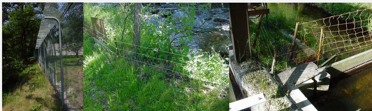
Fig. 30. Recinzioni per impedire l'accesso alle lontre agli allevamenti ittici. Da sinistra: recinzione piegata verso l'esterno per impedire l'ingresso a lontre ed altri animali; fili elettrificati e recinzioni; fili elettrificati e recinzioni in prossimità dei canali d'ingresso e di uscita dell'acqua dall'allevamento (per gentile concessione di Frédéric Leblanc)
