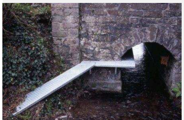
Fig. 29. Misure di prevenzione della mortalità sulla rete stradale. Da sinistra verso destra: (a) uso di recinzioni e tunnel per evitare il passaggio delle lontre su strade trafficate (per gentile concessione di Tim Bernhard); (b) Passaggio per lontre sotto ad un ponte, in Galles in Wales, UK (per gentile concessione di Geoff Liles). Per ulteriori immagini/video si veda:
