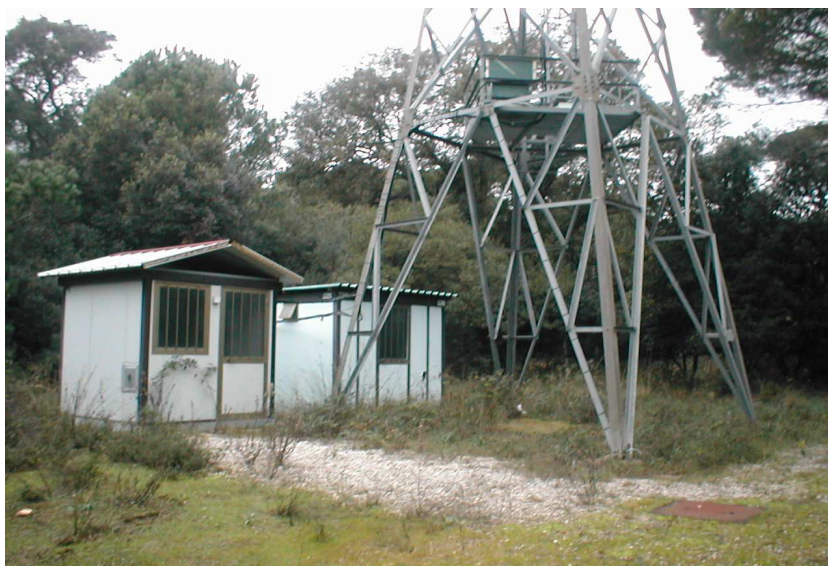
Foto 6.1 – Basamento torre avvistamento n. 1.
