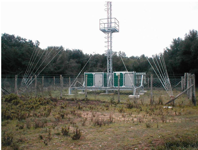
Foto 6.9 –Torre avvistamento n. 5.
