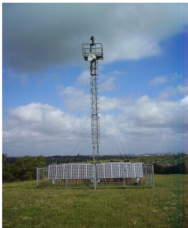
Foto 6.7 –Torre avvistamento n. 4.
