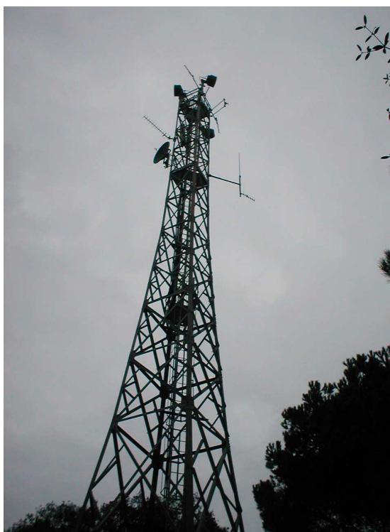
Foto 6.2 – Torre avvistamento n. 1.
