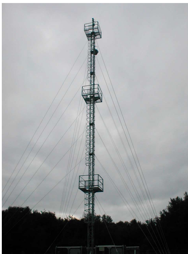
Foto 6.10 –Torre avvistamento n. 5.
