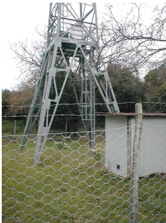
Foto 6.5 – Basamento torre avvistamento n. 3.
