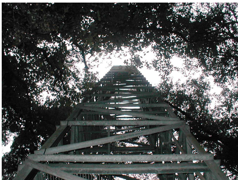
Foto 6.4 –Torre avvistamento n. 2.
