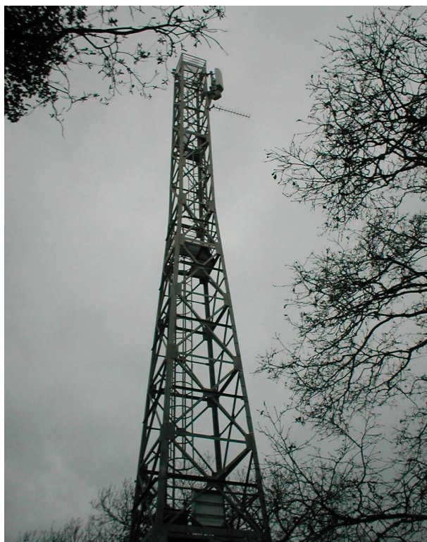
Foto 6.6 – Torre avvistamento n. 3.
