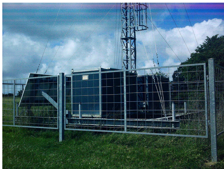
Foto 6.8 – Basamento torre avvistamento n. 4.
