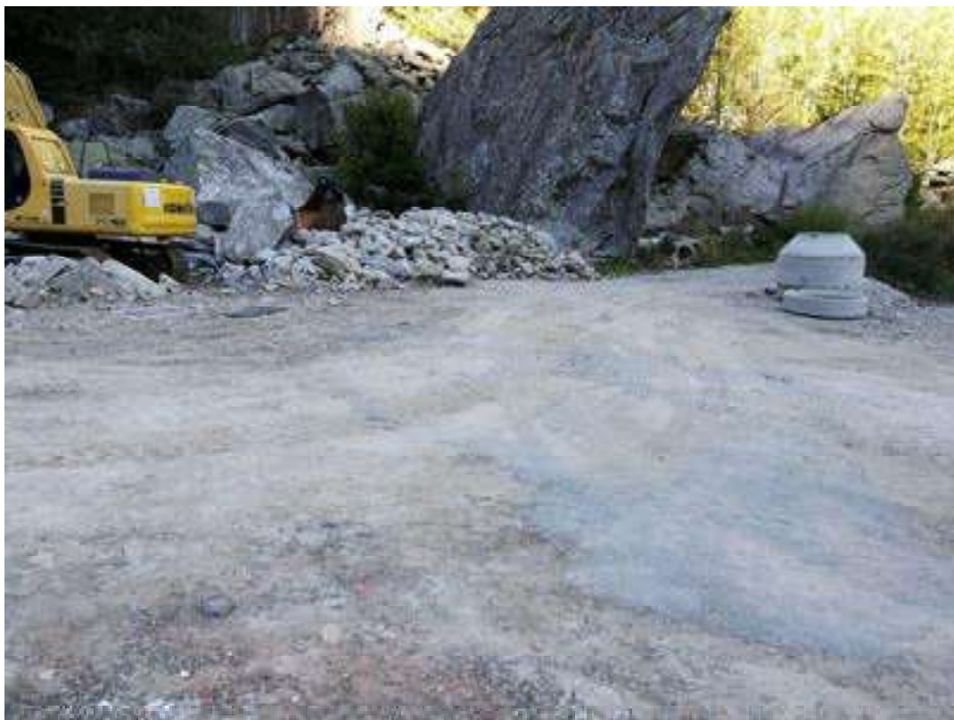
Area per il montaggio della vasca.
