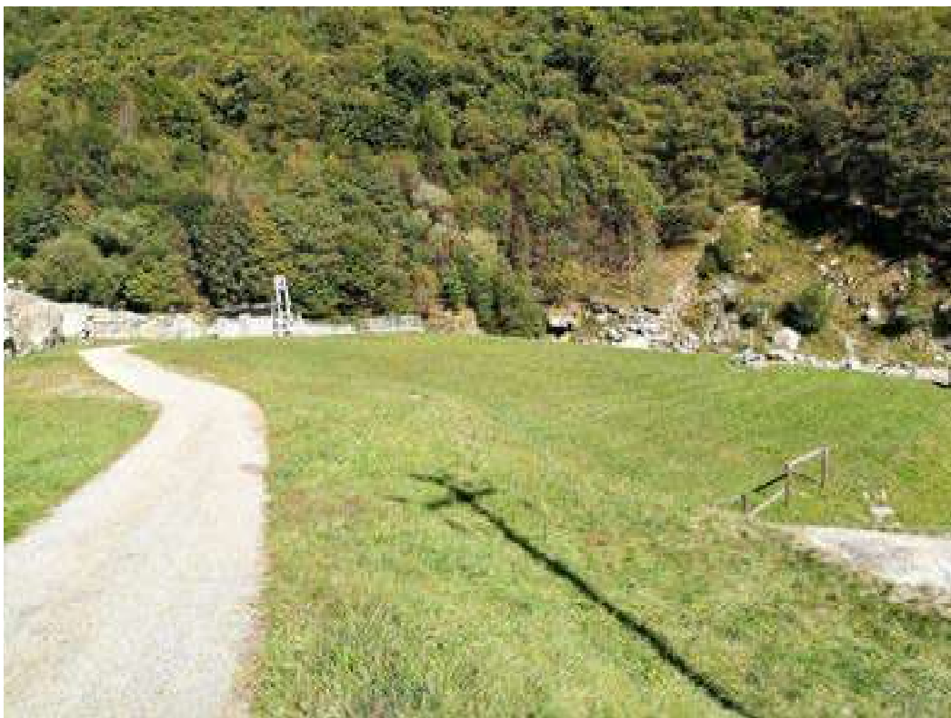
Area per il montaggio della vasca.
