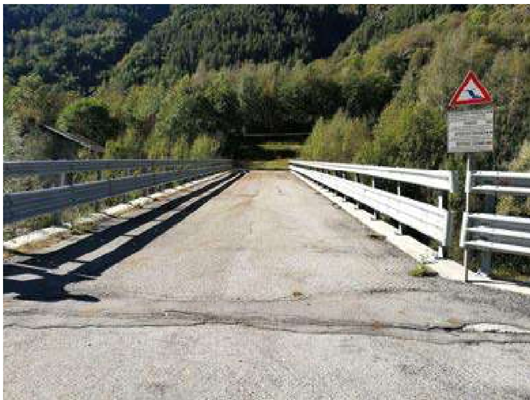
Area per il montaggio della vasca.
