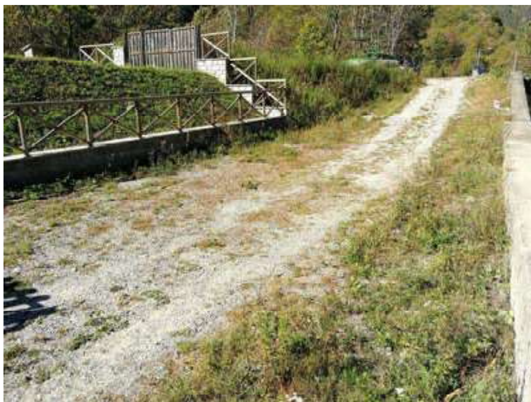
Area per il montaggio della vasca.
