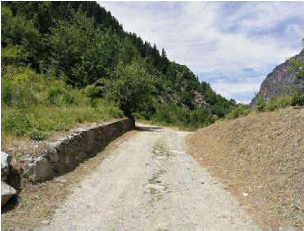
Pista di accesso alla frazione Sylvenoire – verso l'area di montaggio vasca
