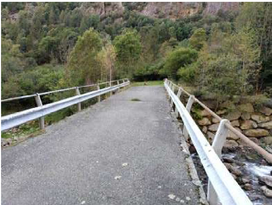
Area per il montaggio della vasca.
