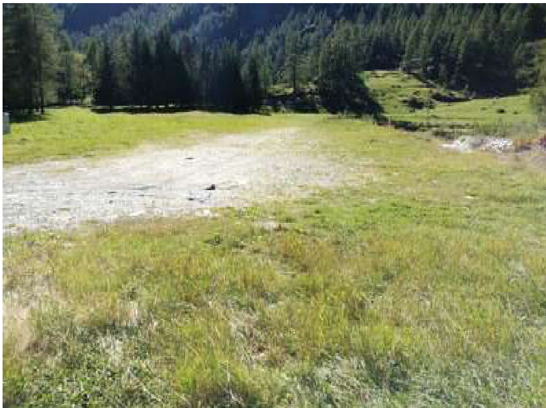
Area per il montaggio della vasca.
