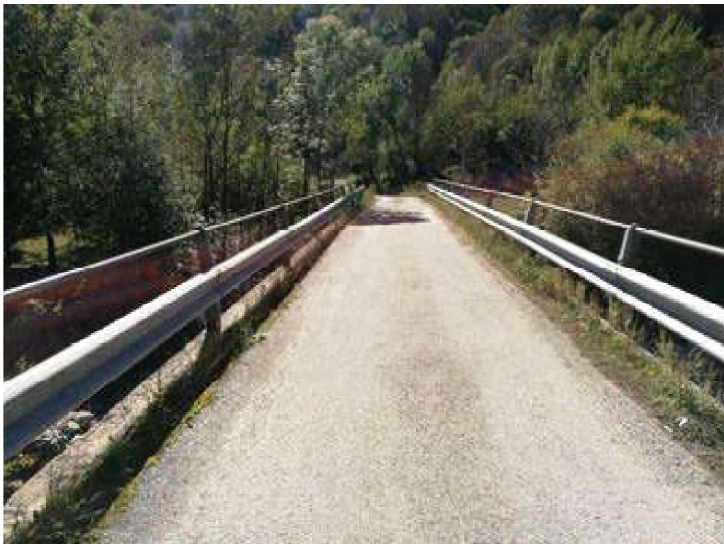
Area per il montaggio della vasca.
