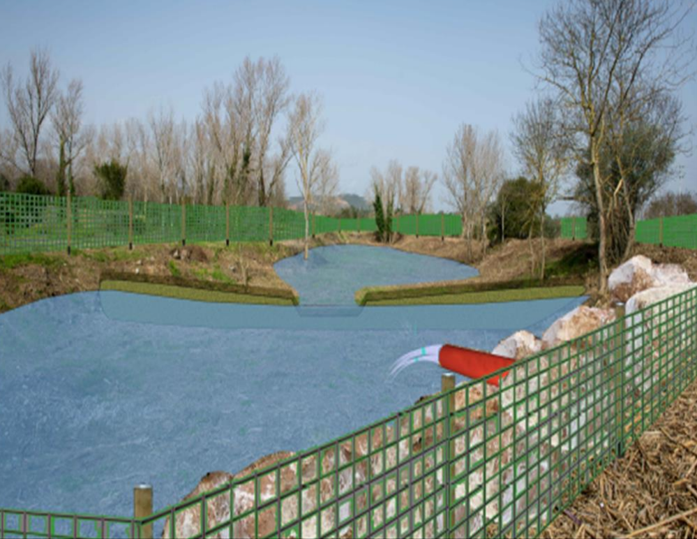
RENDERING VASCA DI SEDIMENTAZIONE E INFILTRAZIONE
