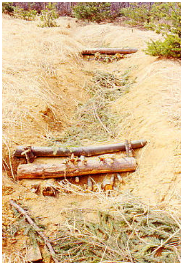
Foto 44 - Regimazione idraulica superficiale con brigliette vive. Millesimo (SV)
