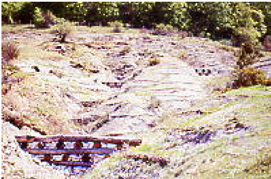
Foto 42 - Sistemazione di versante calanchivo con tecniche di I.N. Monte Aquilone (RI)
