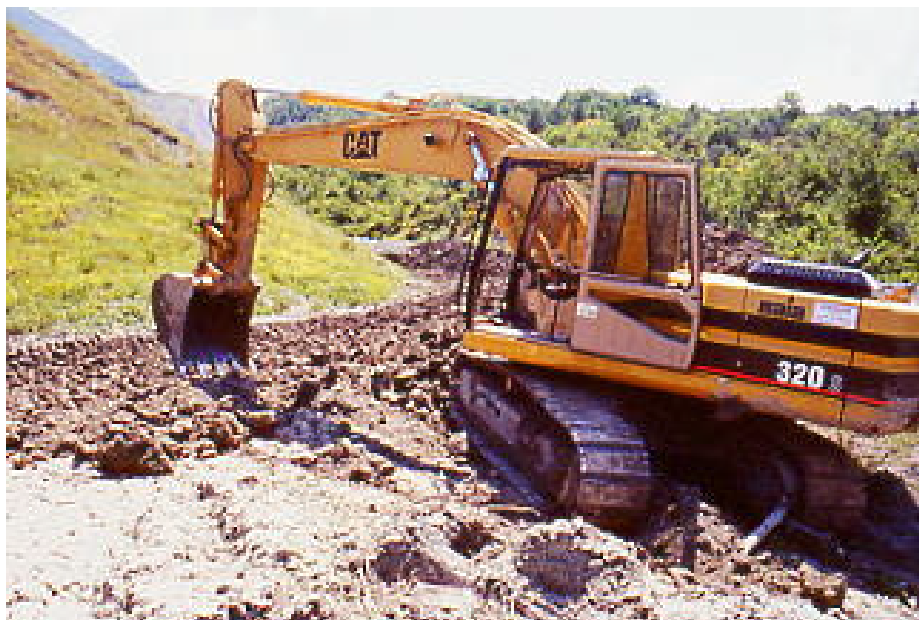
Foto 13 - Lavori di regimazione idraulica - Anversa degli Abruzzi (AQ)
