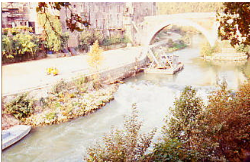
Foto 19 - Ripristino della sezione di deflusso in corrispondenza dei ponti. .F. Tevere Roma
