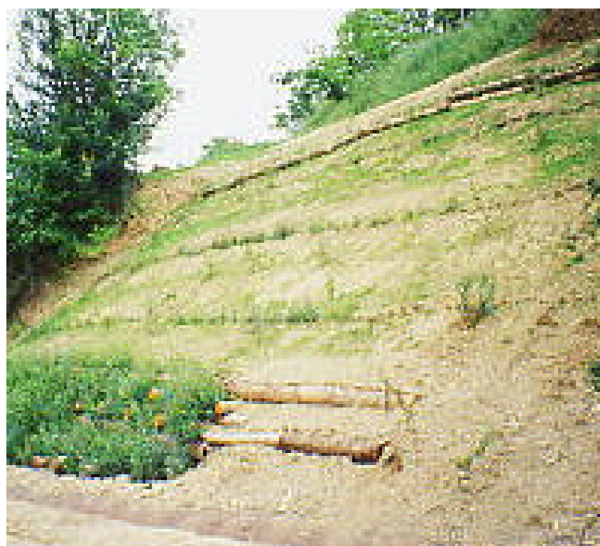
Foto 11 - Intervento di sistemazione della frana della foto10 con tecniche di ingegneria naturalistica, a 3 mesi dalla fine dei lavori. Atina (FR)
