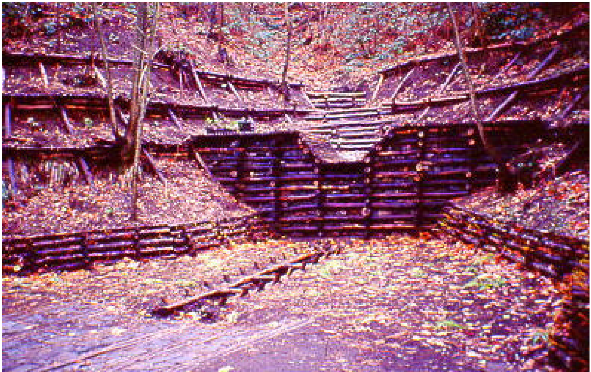
Foto 38 - Regimazione idraulica con briglie in legname e pietrame, grate vive e palificate vive nel P. Nazionale del Vesuvio (NA)
