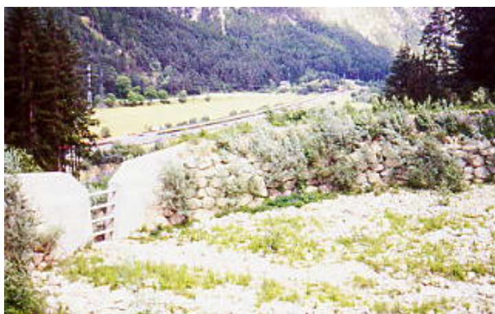
Foto18 - Lo svuotamento periodico delle briglie selettive è necessario per il ripristino dell'efficienza dell'opera. Alto Adige
