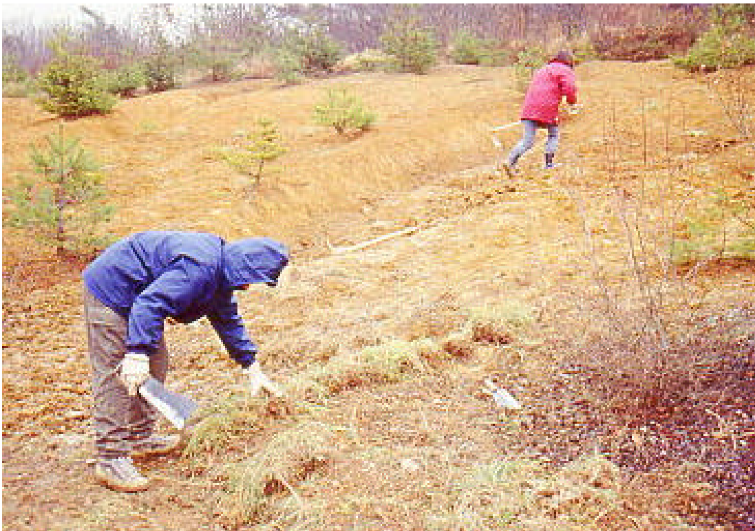
Foto 43 - Interventi antierosivi superficiali: trapianto di zolle erbacee. Millesimo(SV)
