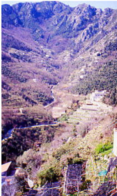
Foto 3 - La legge sulla difesa del suolo (L.183/89), prevede interventi di sistemazione idrogeologica con un approccio sistemico a livello di bacino idrografico. Raito(SA)
