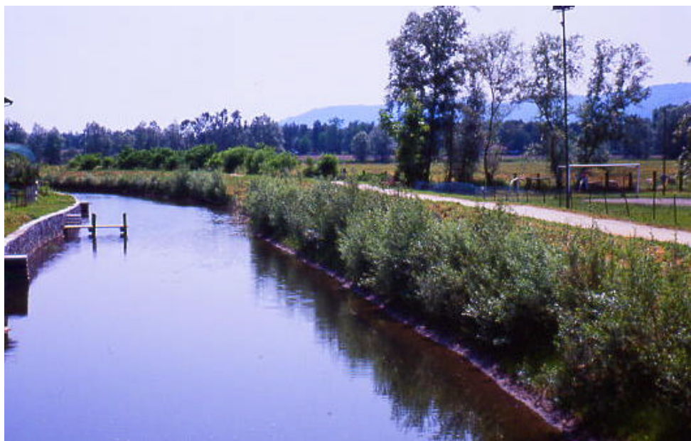
Foto 37 - Palificata viva spondale sul canale di Mergozzo (VB)
