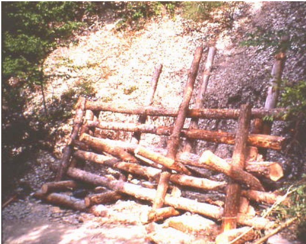
Foto 40 - Palificata viva Roma in fase di costruzione. Cà i Fabbri (PS)
