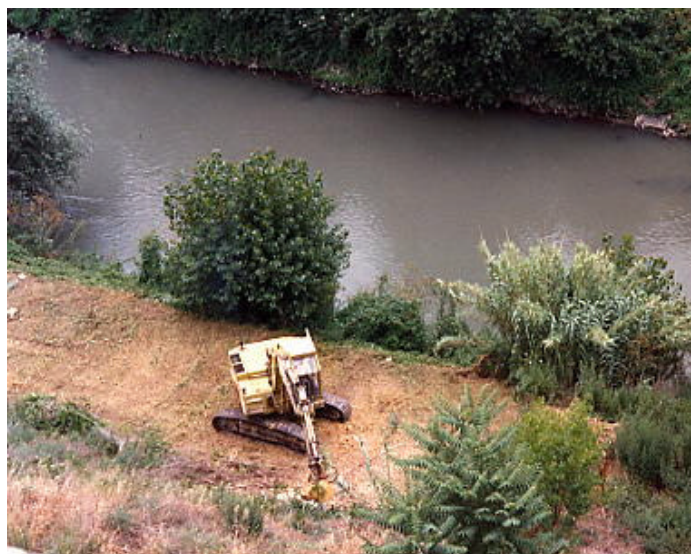
Foto16 - Interventi di manutenzione sugli argini del F.Aniene. Roma
