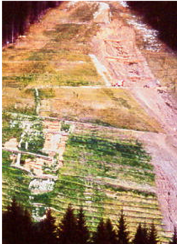
Foto 36 - Sistemazione di aree instabili con tecniche di ingegneria naturalistica. (TN)
