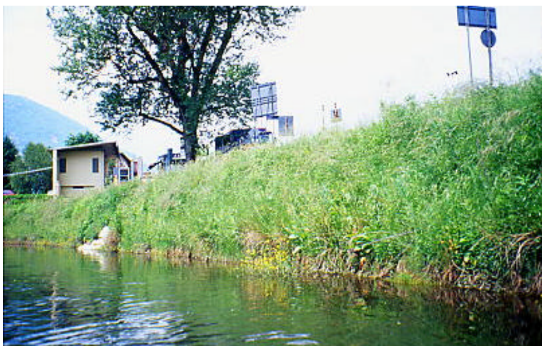
Foto 45 - Terra rinforzata rinverdita sulla sponda del canale di Mergozzo (VB)
