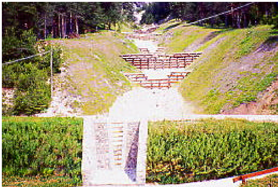
Foto 39 - Sistema di briglie con tecniche di ingegneria naturalistica. Tarvisio (UD)
