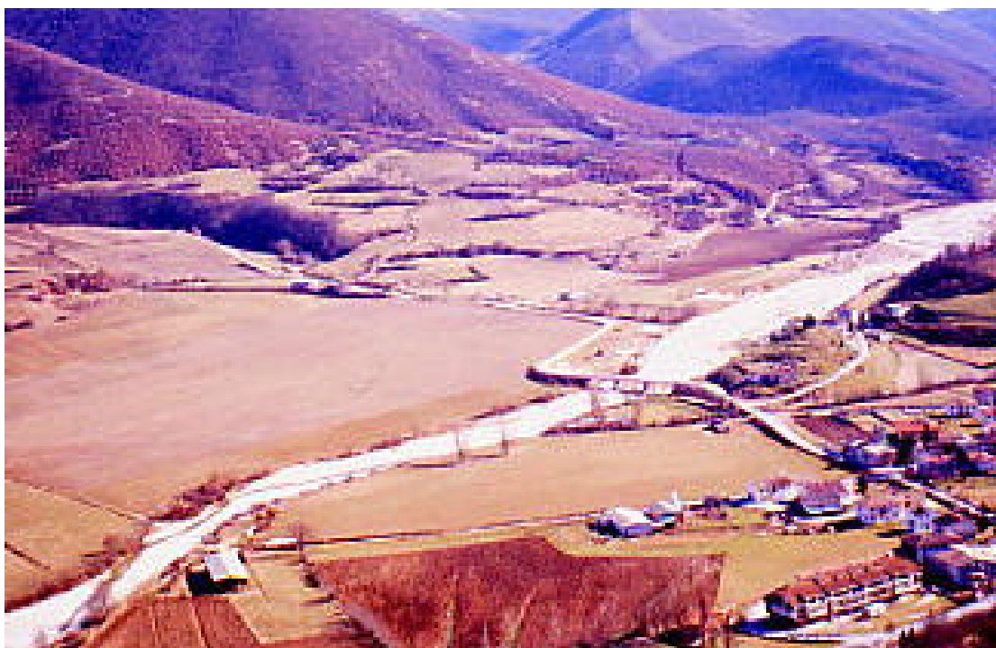
Foto 17 - La rinaturazione delle sponde ed il restauro dell'ecosistema ripariale sono uno dei principali interventi di manutenzione sui corsi d'acqua. Monteleone di Spoleto(TR)
