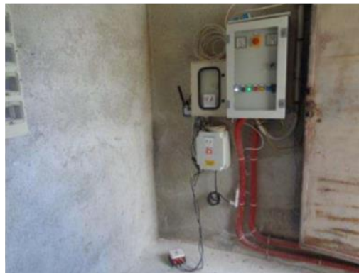
Figura 490 - Esempi di stazioni della RAN installate in modo semplificato sul pavimento di piccoli locali
