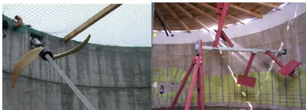
Figura 3-66 Dispositivi di miscelamento
