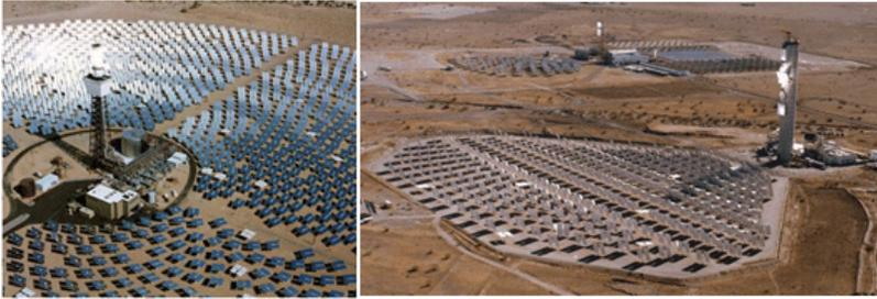
**Figura 3-23** Differente distribuzione degli eliostati
