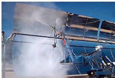
**Figura 3-28 Pulizia degli specchi del campo solare**
