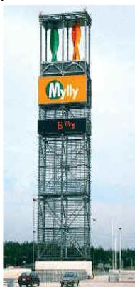
**Figura 3-41 Aerogeneratore ad asse verticale**
