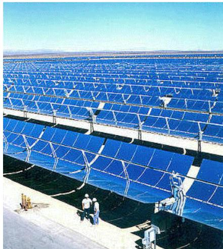
Figura 3-17 Campo si concentratori parabolici lineari
