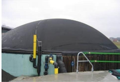
Figura 3-64 Copertura a membrana
